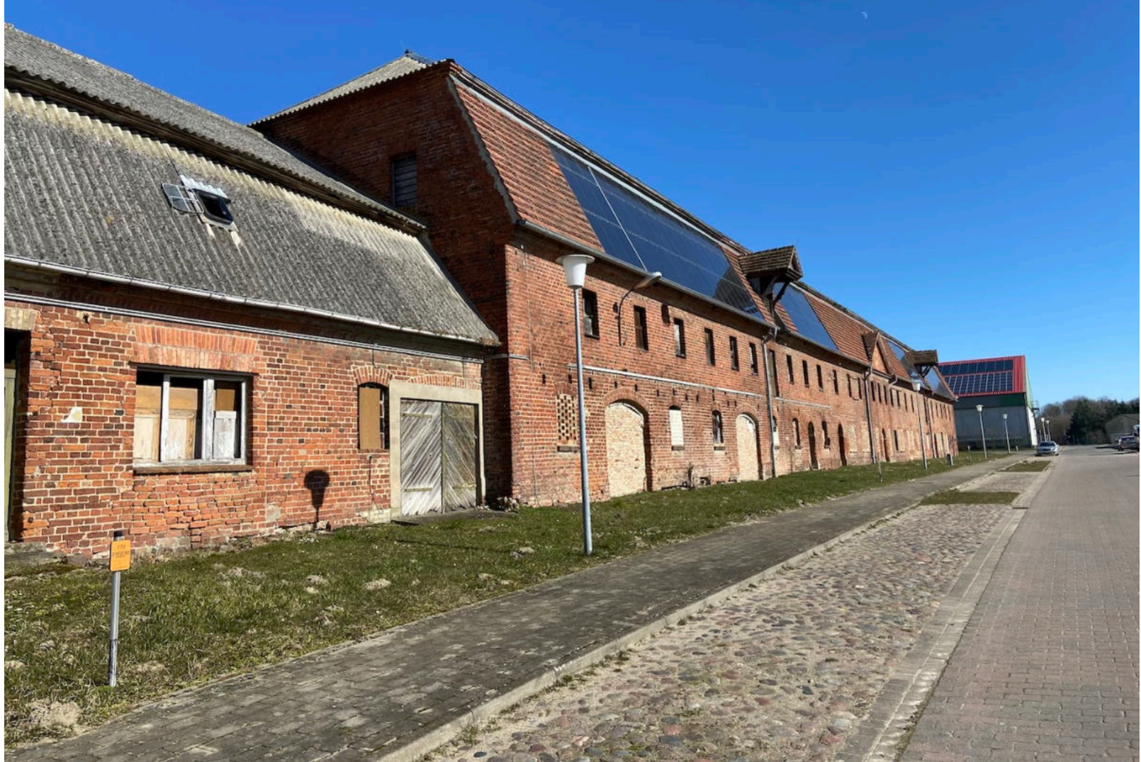
Abb. 4: Fassade Südseite, Foto 2022
