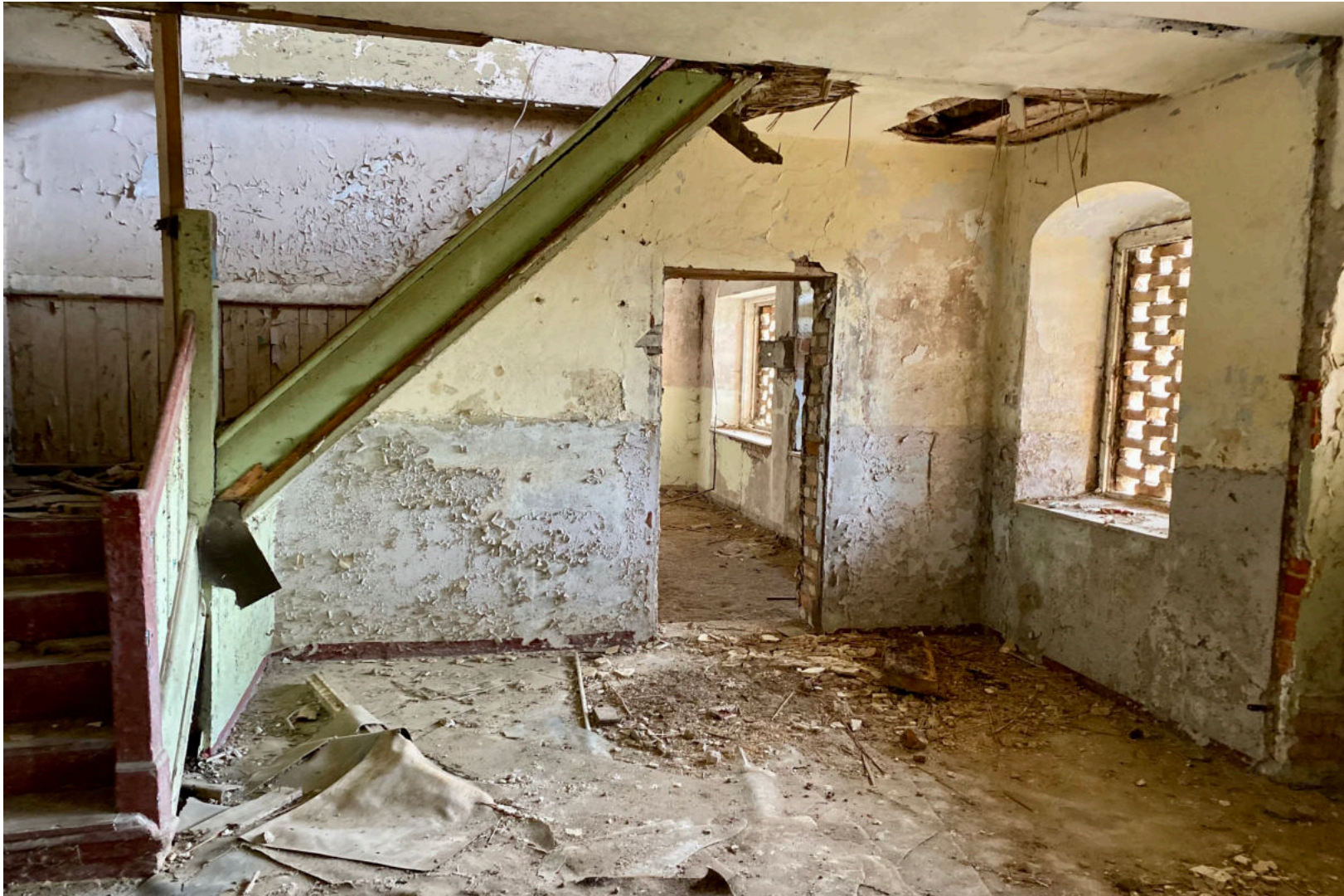
Abb. 15: Erdgeschoss Mittelbau, Foto 2022
