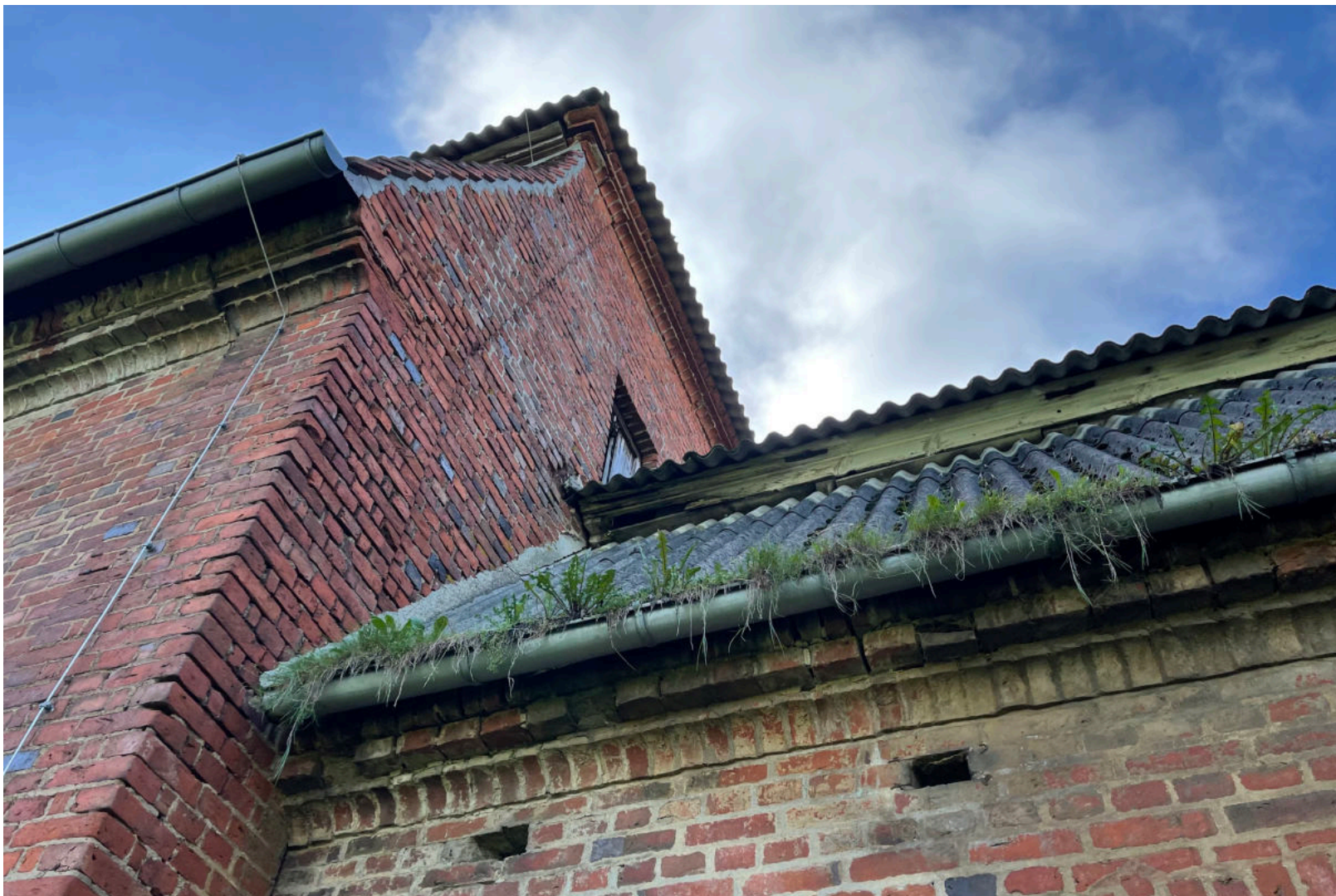
Abb. 12: Fassadendetail Nordseite, Foto 2022
