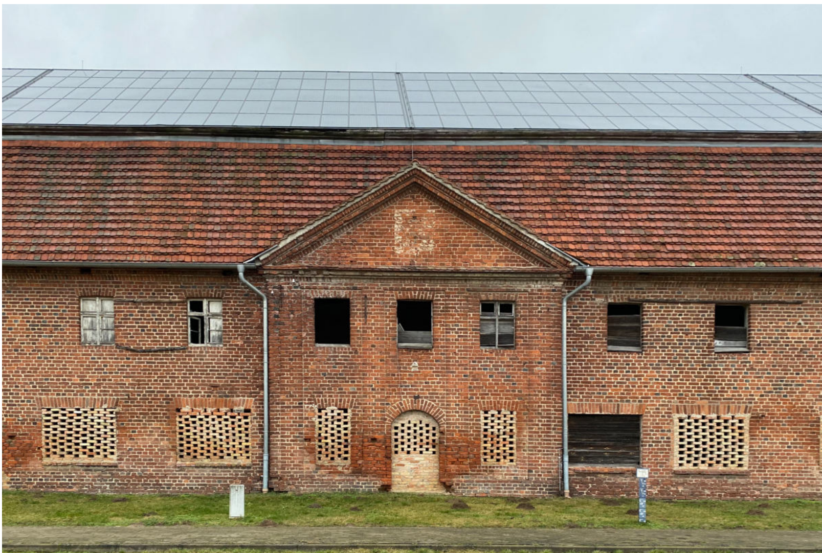
Abb. 11: Fassade Südseite, Foto 2022
