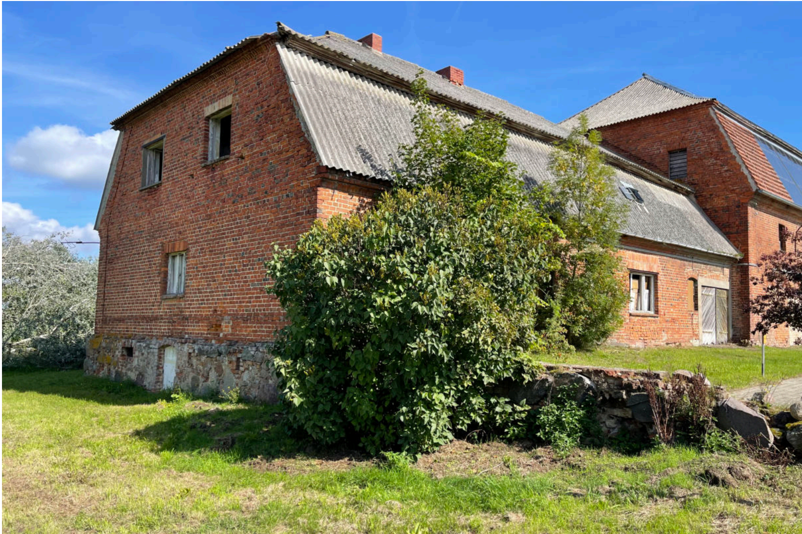
Abb. 13: Fassade Südseite, Foto 2022
